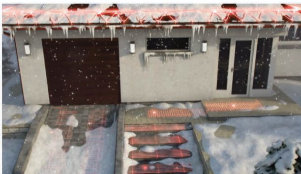
یخ زدایی سیستم گرمایشی شیروانی، رمپ و راه پله
